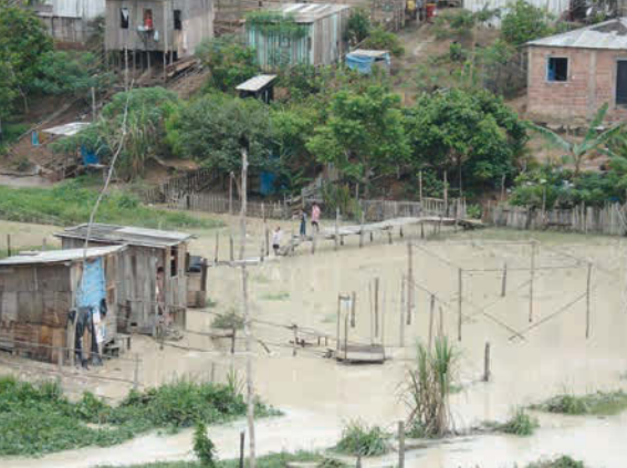
En construisant passerelles et maisons sur pilotis, les gens se protègent du niveau d'eau qui change perpétuellement
