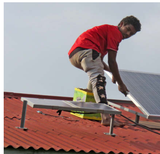
Le centre de formation à Ashaiman sera équipé d'un toit permettant
