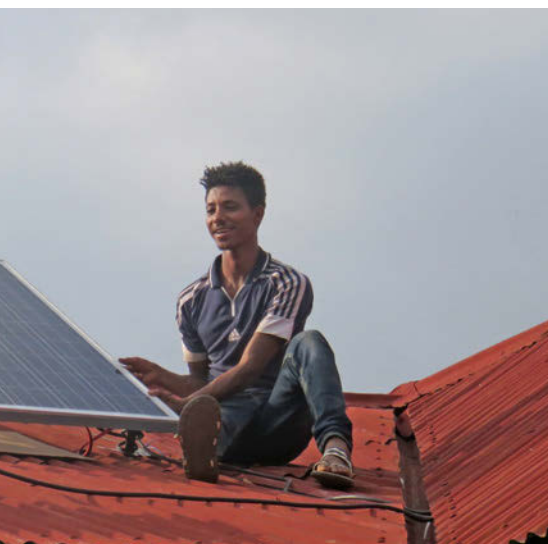
de s'exercer au montage et au démontage des installations solaires
