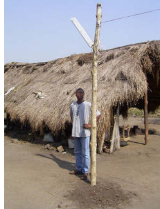
Ce réverbère solaire installé le jour...
